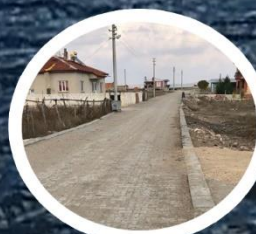
Alt ve Üst Yapı Çalışmaları
